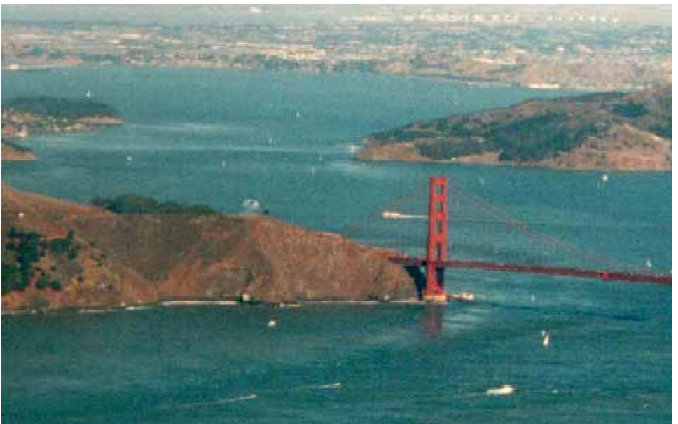
Golden Gate San Franciscon lahden päältä nähtynä.
